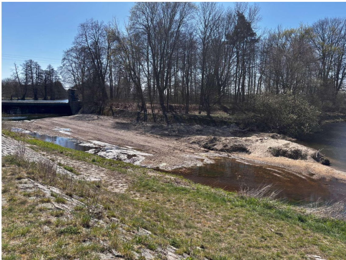
Obr. Nános pod stávající válcovým jezem (3/2025) – lokalita Čermná
